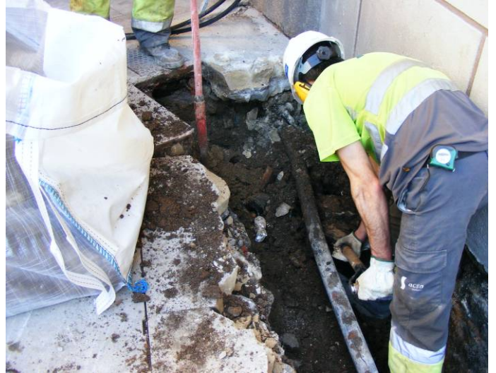
4. Retirada de la UE 3.
