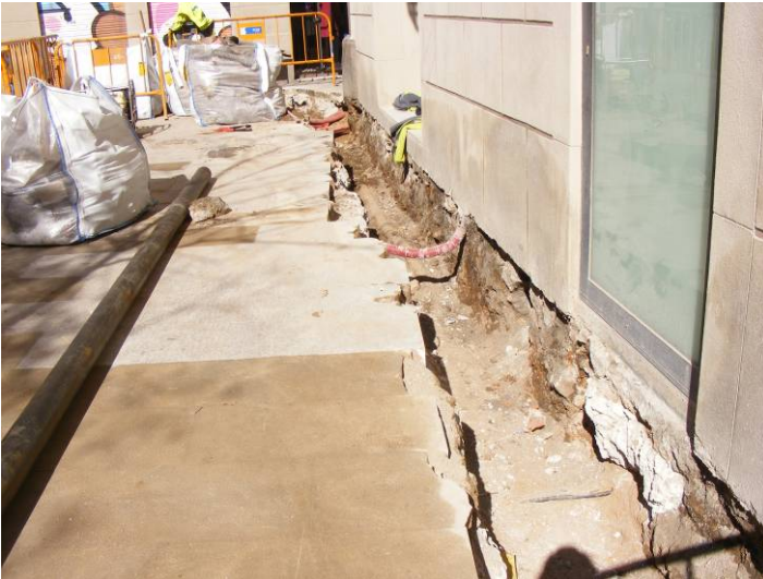
7. Imatge final de la rasa.
